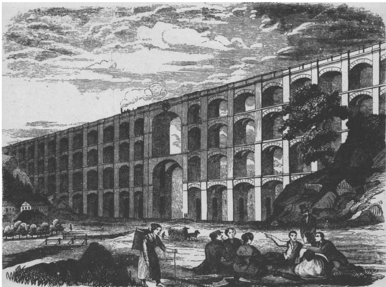
Viadukt přes údolí Göltzschské v Sasku z roku 1851.
